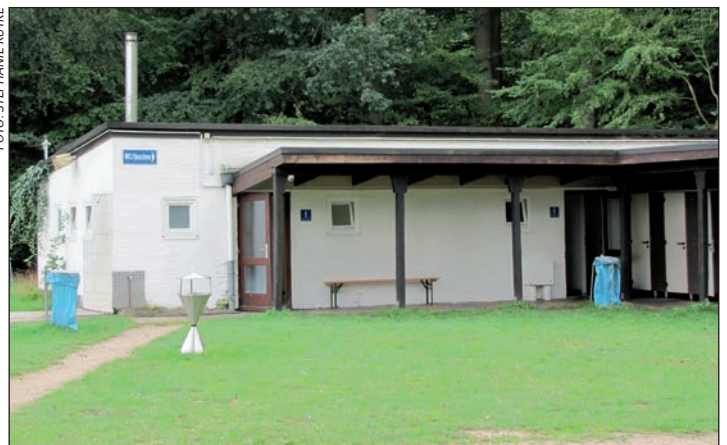
Der Sanitärtrakt soll erneuert werden.
