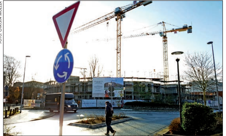
Hier an der Hamburger Landstraße entsteht der Zöllhof Wentorf.
