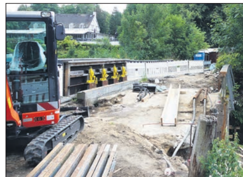
Die Sanierungsarbeiten an der maroden Brücke sind in vollem Gange.
