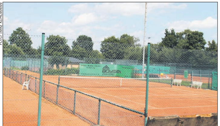
Zwei der sechs Tennisplätze werden im nächsten Jahr nicht mehr ohne Sanierung beispielbar sein
