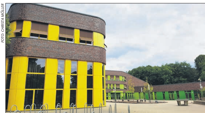
Derzeit wird noch geprüft, ob die Belüftungsanlage des Kinderzentrums, dessen Fenster nicht zu öffnen sind, eine mögliche Virenlast verringert.
