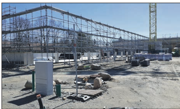
Die eingerüstete Fahrzeughalle, hinten der fast fertige Südtrakt.
