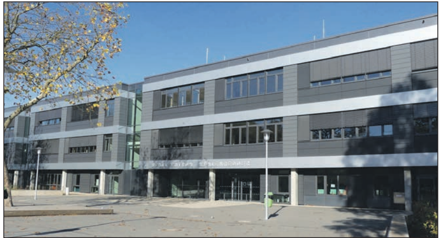
Das Schulzentrum Mühlenredder gehört zu den modernsten Schulbauten im Land.
