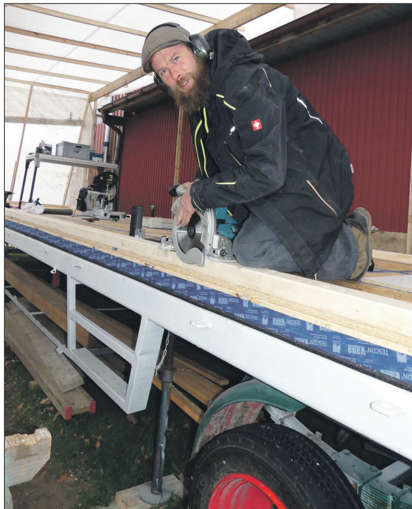
Tischler Nils Drabner ist dabei, das Holzständerwerk für den Bauwagen zu fertigen.
