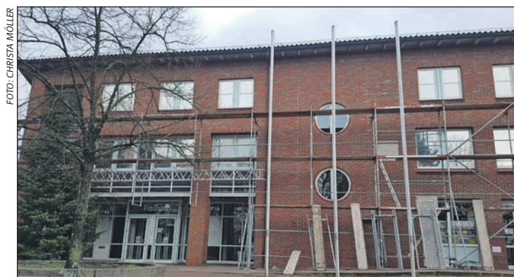
Das Rathaus wird für die Installation der umweltfreundlichen Energieerzeugung eingerüstet.
