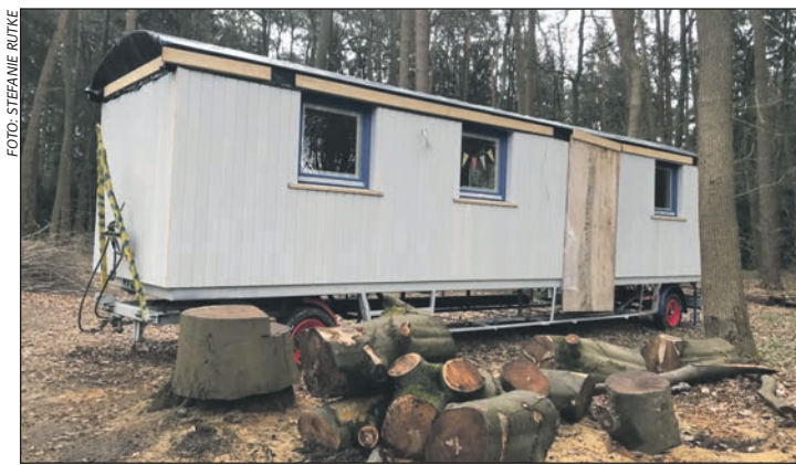
Der Bauwagen hat wieder ein Dach und Wände.
