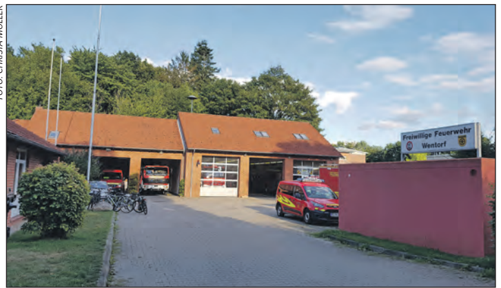
Das alte Feuerwehrgerätehaus ist längst zu klein.
