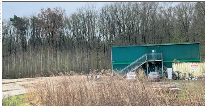
Auf dem freien Grundstück an der Schanze 60 soll schon bald weiterer Wohnraum für rund 40 Geflüchtete entstehen
