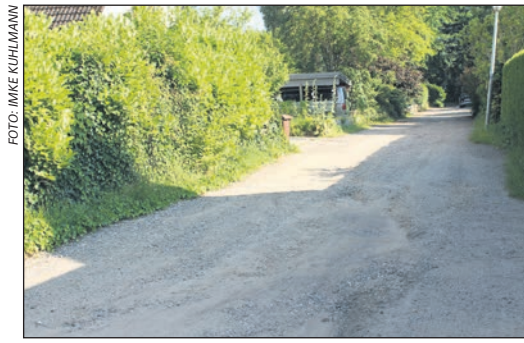
Die Straße Am Schulbrook ist je nach Wetterlage nahezu unbefahrbar
