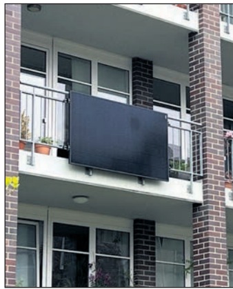
Stecker-Solaranlage. Bildquelle: Milena Schuldt, ZEBAU GmbH
