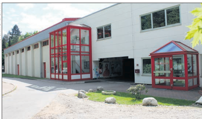
Die Sanierungsarbeiten der Uwe-Plog-Halle gehen in den letzten Bauabschnitt
