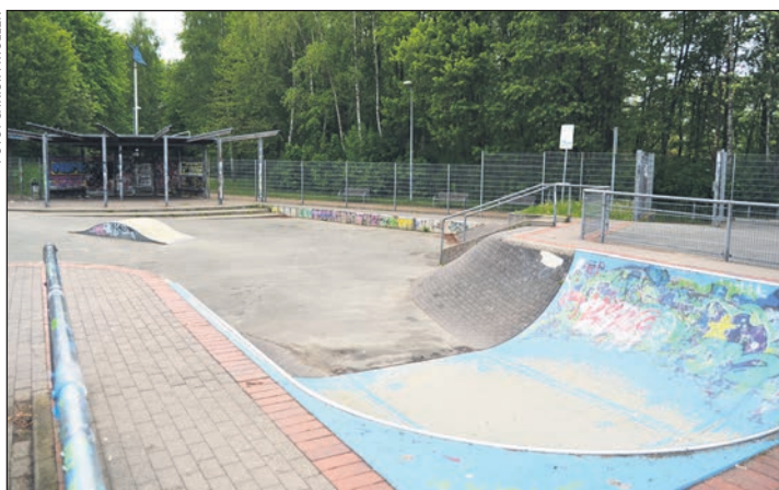
Die Skateranlage am Jägerstieg ist erneuerungsbedürftig.
