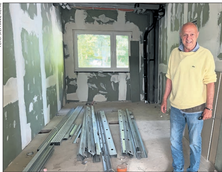
Stefan Bormann, Vorsitzender des TuS Aumühle-Wohltorf, steht in dem Raum, in den die neue Küche eingebaut wird.
