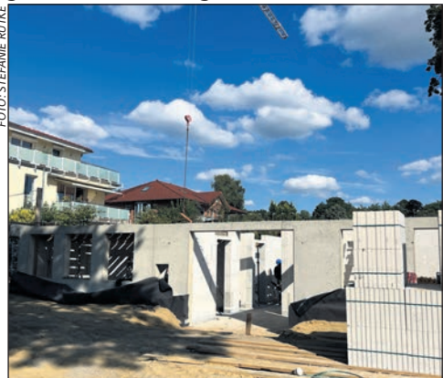
Der Neubau der Schwesternstation wächst schnell.
