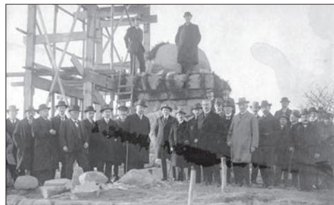
Richtfest Denkmal in Wentorf, Frühjahr 1925
