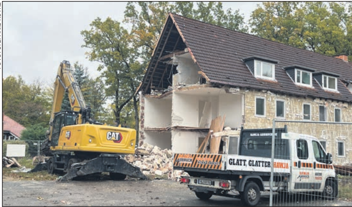
Der Abriss der alten Objekte in der Straße »An den Pappeln« hat begonnen.
