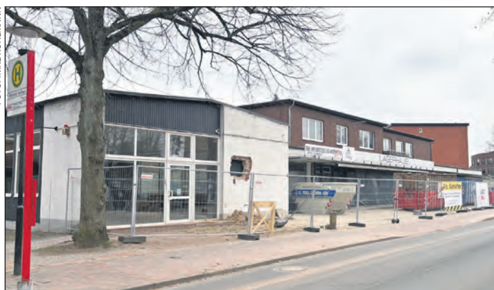
Die Rückbauarbeiten haben bereits begonnen
