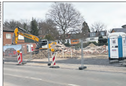
Der Bau wurde Ende März abgerissen
