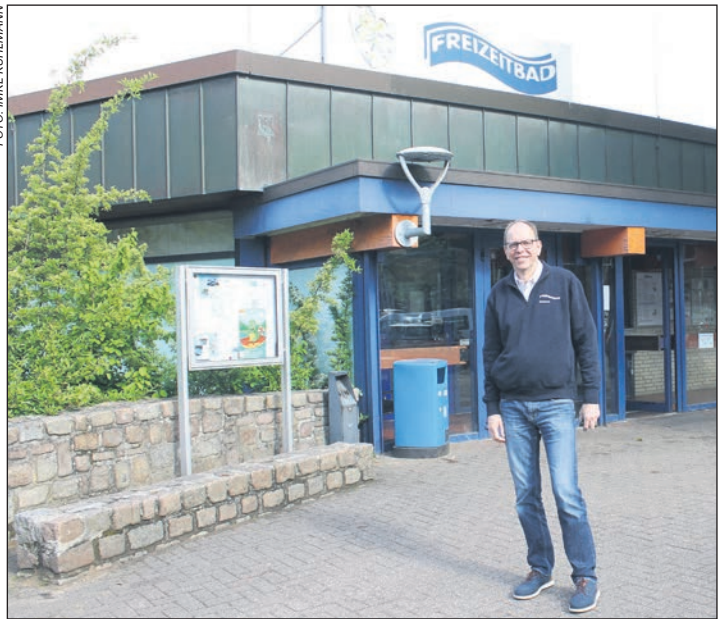
Holger Kehl bereitet die Sanierung akribisch vor
