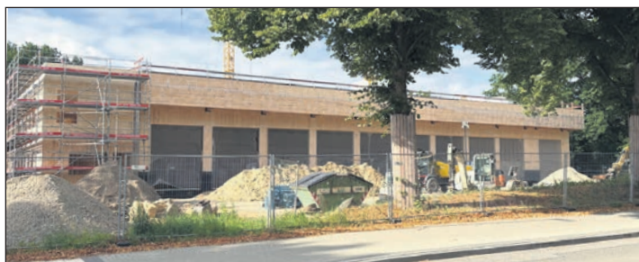
Der Neubau der Feuerwehr macht sichtbare Fortschritte
